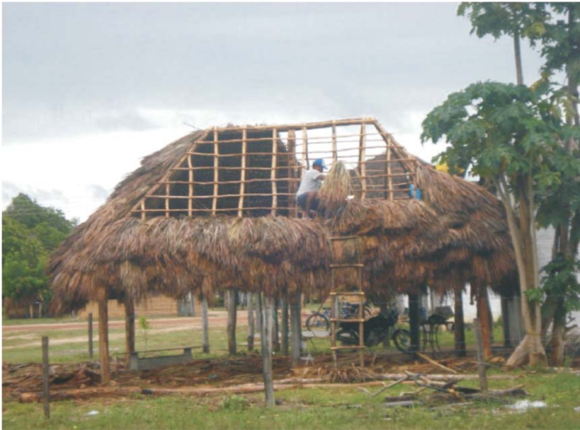
FIGURA 6. Casa sendo coberta com palha de buriti na TI Araçá (comunidade Araçá).
